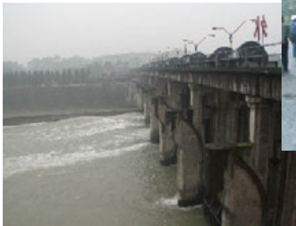
外江に設けられた水門とモーター。
