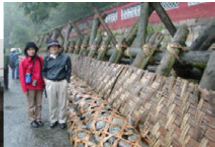
昔、工事に使った木の杭と石を詰めた蛇籠。杭を縛る縄は竹の皮を編んで作った竹縄
